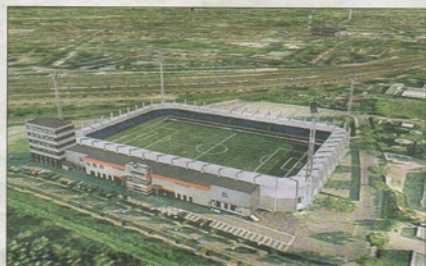
Het RBC-stadion op industrieterrein Borchwerf in elektronische vorm.
